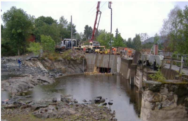
Ørjedammen er tørrlagt for ombygging av vanninntaket til kraftstasjonen.
